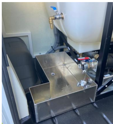
Imagen 15: Toma de agua con pileta
